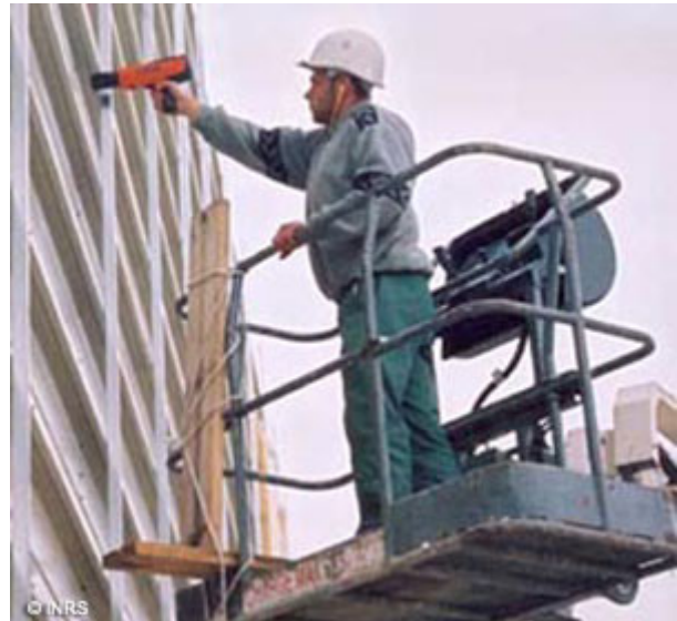
Poste de travail en position maintenue : bardage en façade
